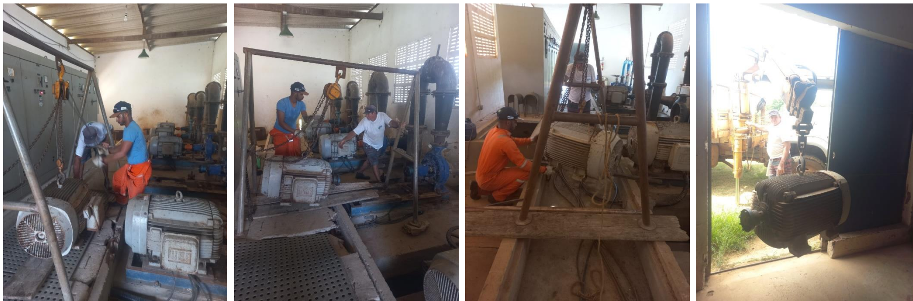
Figura 8 – Troca de motor da EB 10 para EB 11, com objetivo de restaurar a pressão do sistema hídrico.
