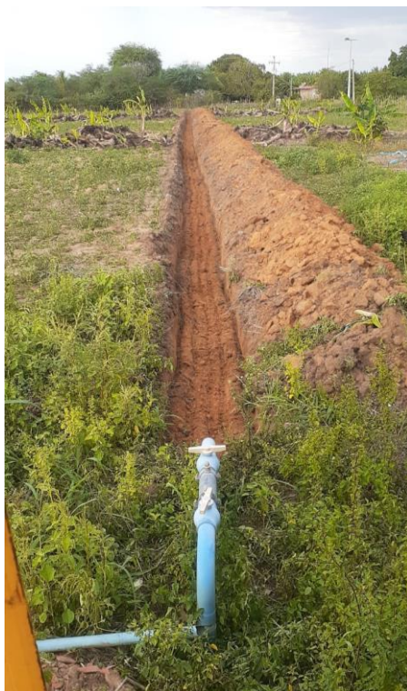
Figura 12 – Serviço de escavação de valas e limpeza dentro do Lote Familiar 09, do Setor 1.
