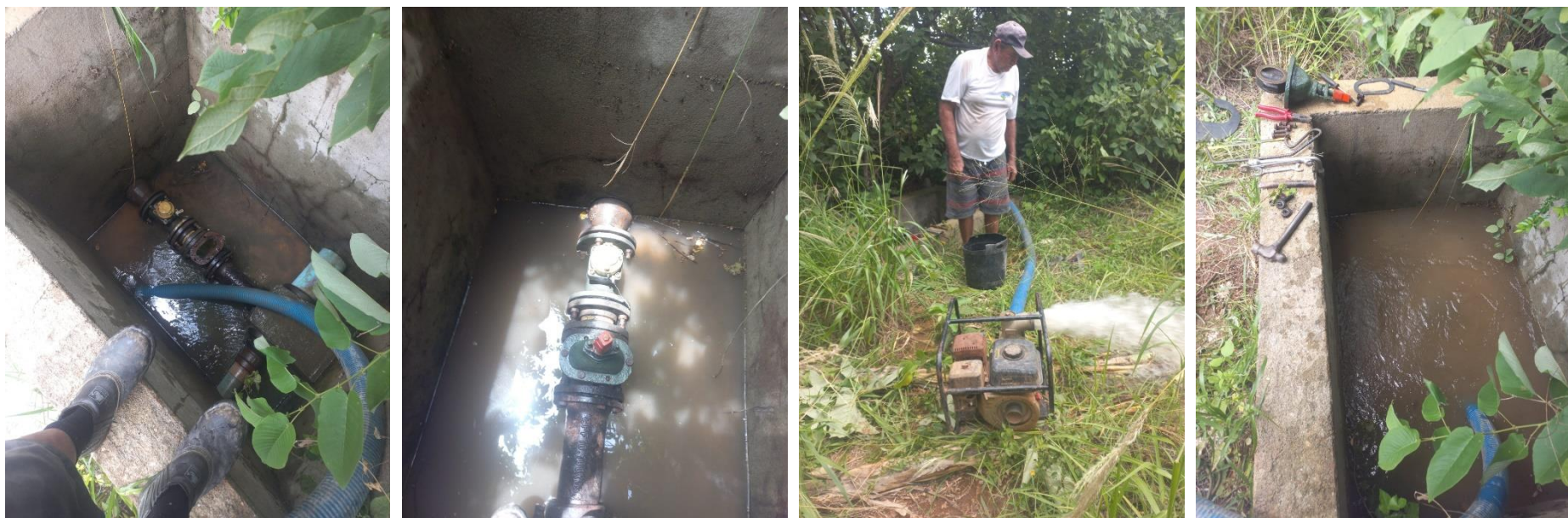
Figura 7 – Instalação de registro de entrada de água no Lote Familiar 97 do setor 10.
