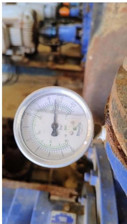
Figura 19 – Monitoramento da pressão das bombas após a montagem da bomba com rotor que foi dado um passe.
