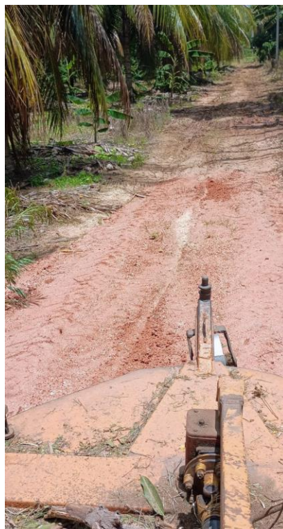
Figura 10 – Roço da estrada que dá acesso ao Lote Familiar 65, do Setor 5.
