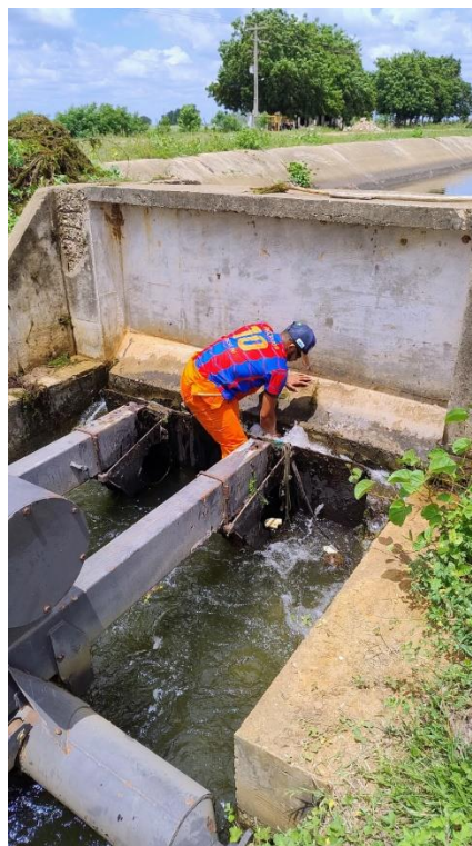
Figura 18 – Limpeza da comporta 2, retirada do lodo.
