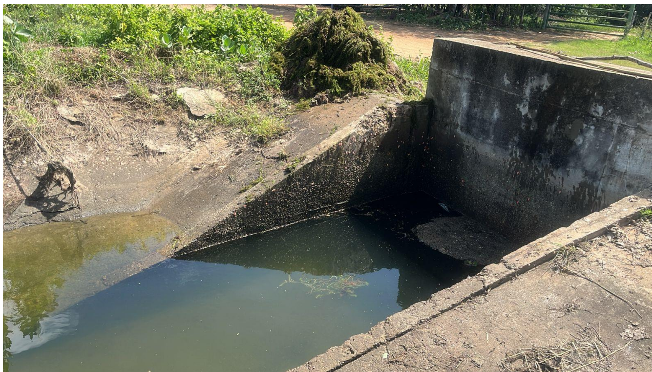
Figura 16 – Manutenção de limpeza na comporta 3.
