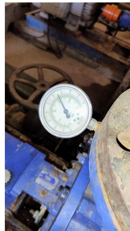
Figura 19 – Monitoramento da pressão das bombas após a montagem da bomba com rotor que foi dado um passe.
