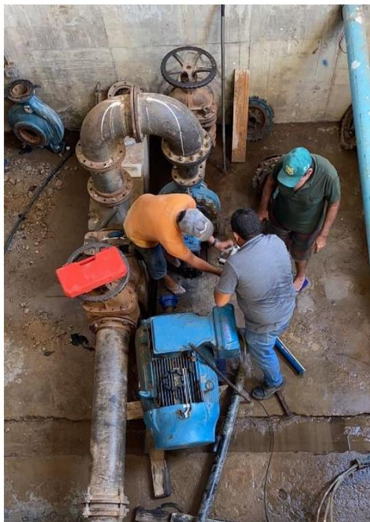
**Figura 6** – Montagem do registro de 800 mm no canal da 2<sup>o</sup> etapa.
