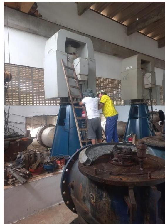
**Figura 5** – Montagem do motor da base 2 da EB 1.
